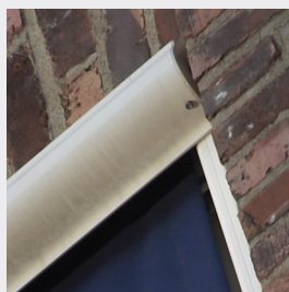
MT74 har en kassett i strängpressat aluminium
